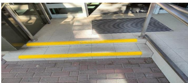
Zdjęcie nr 29: oznaczenie kontrastowe początku i końca biegu schodowego
