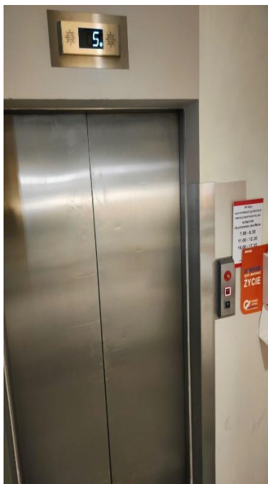
Zdjęcie nr 6: dźwig osobowy drugi, wejście
