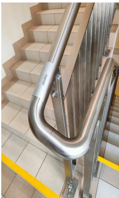
Zdjęcie nr 36: oznaczenie poręczy przyschodowych pismem Braille'a
