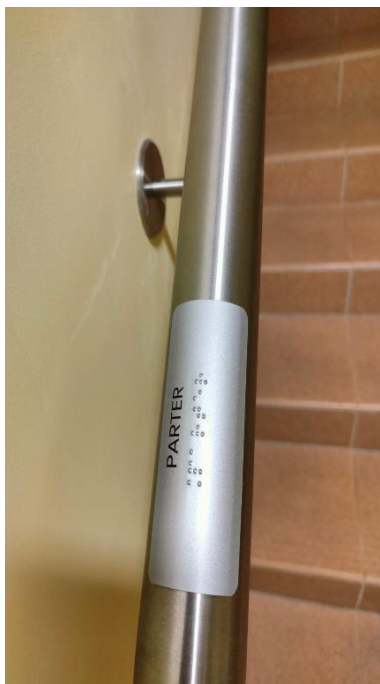
Zdjęcie nr 35: oznaczenie poręczy przyschodowych pismem Braille'a
