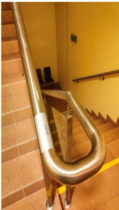
Zdjęcie nr 34: oznaczenie poręczy przyschodowych pismem Braille'a
