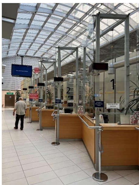
Zdjęcie nr 2: Brak pętli indukcyjnych w punktach rejestracji
